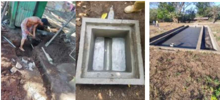
Bilder 2.b ): Trink und Abwasserprojekte: Konstruktion von Hausanschlüssen und Absetzteichen, System zur Vorbehandlung. Wachhäuschen für das Wachpersonal.
