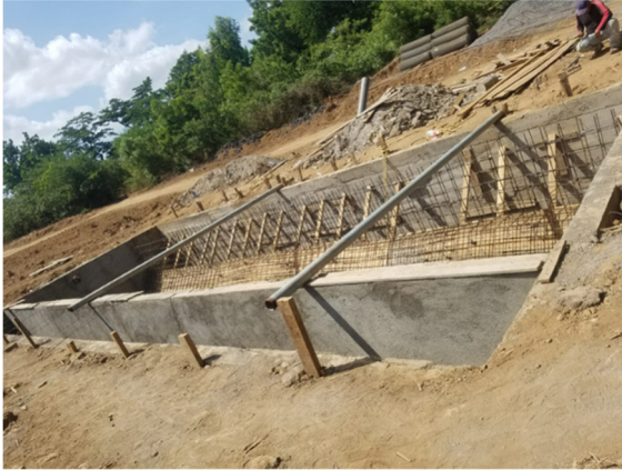
Bilder 2: Trink- und Abwasserprojekt. Bau eines Aufbereitungssystems (Imhoff-Tank).
