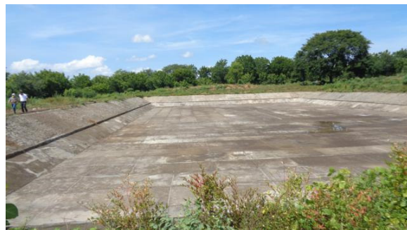
Bilder 3: Trink und Abwasserprojekte: Konstruktion von Hausanschlüssen und Reifungslagune.
