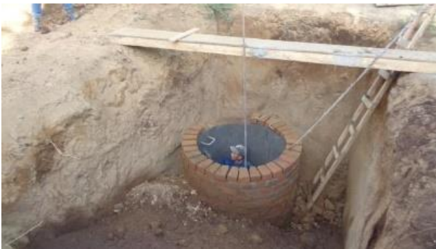
Bilder 3a ,3b: Trink und Abwasserprojekte: Konstruktion von Inspektionsschächten und des Systems zur Vorbehandlung.
