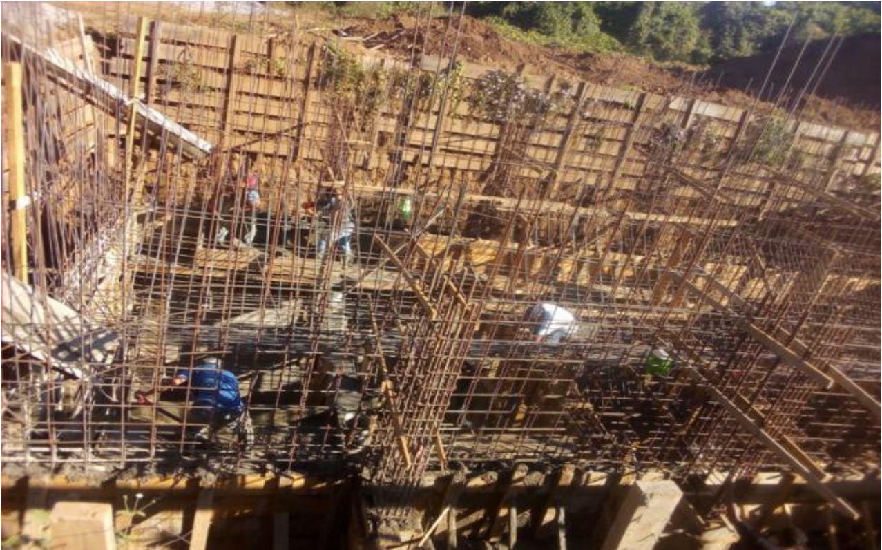
Bild 2: Trink- und Abwasserprojekt. Bau eines Aufbereitungssystems (Imhoff-Tank).
