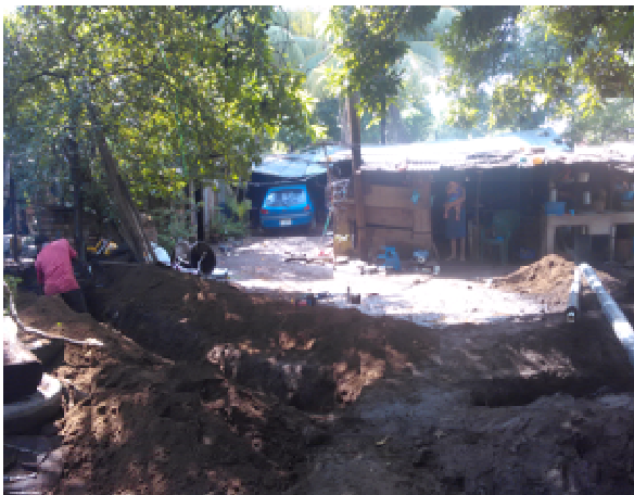
Bild 4: Ausgrabungen für die Installation von Röhren Bild 5: Aushub eines Kontrollschachts in Altos de Veracruz
