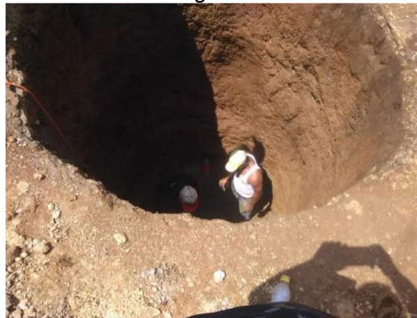
Bild 4: Ausgrabungen für die Installation von Röhren Bild 5: Aushub eines Kontrollschachts in Altos de Veracruz
