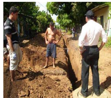
Baugrube: Kanalisation
