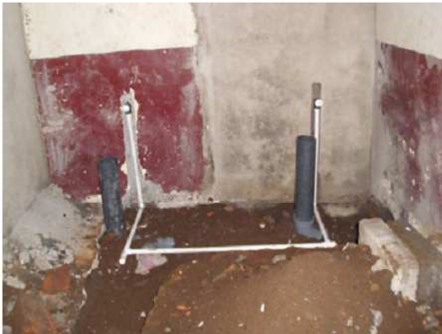
Rohrleitung fertig (nachher)
