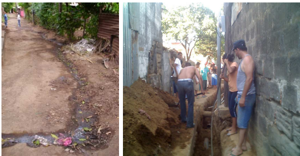
Ohne Hausanschlüsse: Bau der Hausanschlüsse Abwasser auf der Straße
